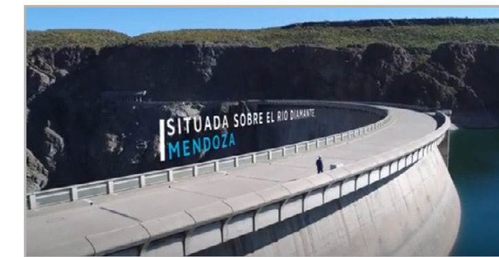
Central Hidroeléctrica Diamante
