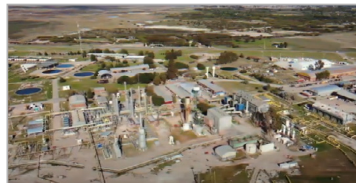
Central de Co-Generación Ecoenergía
